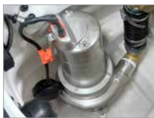
BOMBA SUMERGIBLE DE ACERO INOXIDABLE DE ALTA EFICIENCIA PARA APLICACIÓN INDUSTRIAL
