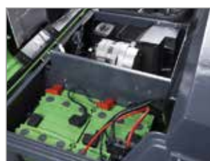
DUAL POWER CON MOTOR DIESEL
