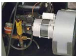
MOTOR MONOFÁSICO DE CALDERA, ACOPLADO DIRECTAMENTE AL VENTILADOR Y A LA BOMBA DIESEL
