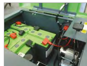
ALOJAMIENTO DE BATERÍAS (1280 E)
