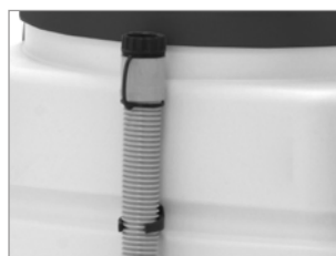
MANGUERA DE DRENAJE
