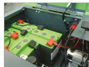
ALOJAMIENTO DE BATERÍAS (1250 E)
