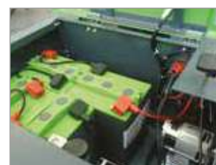
ALOJAMIENTO DE BATERÍAS (1250 E)
