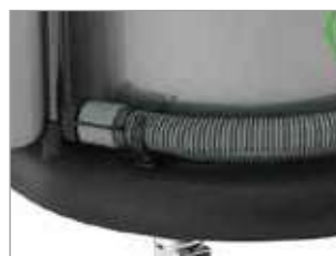
MANGUERA DE DRENAJE
