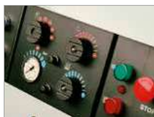
PANEL DE CONTROL CON APAGADO DE EMERGENCIA
