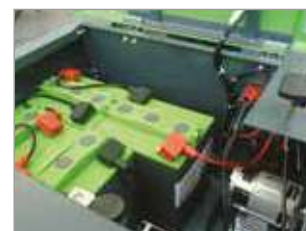
ALOJAMIENTO DE BATERÍAS (1250 E)
