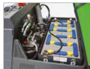
ALOJAMIENTO DE BATERÍAS
