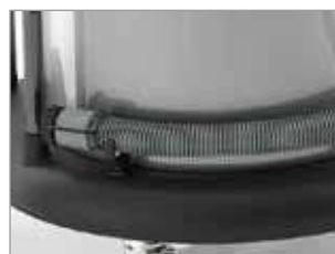
MANGUERA DE DRENAJE
